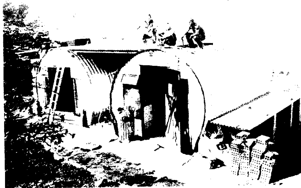
Langt om længe kom der gang i byggeriet på D 01. Her er det Hest, Rehn og "Michael Højrehånd" der har fået lagt nyt tag på.
